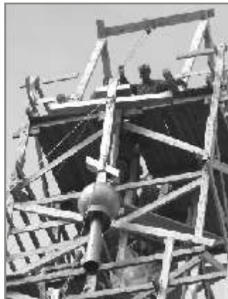
3 Реставрация полным ходом
